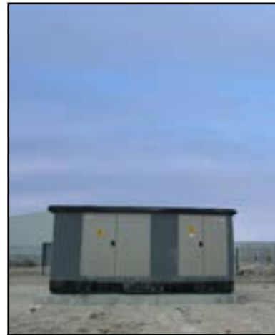
Trafo Merkezi Binaları
