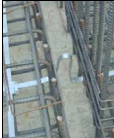
Topraklama ve Yıldırımdan Korunma Tesisleri
