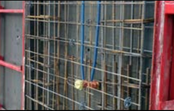
Tünel Kalıplı Tesisler
