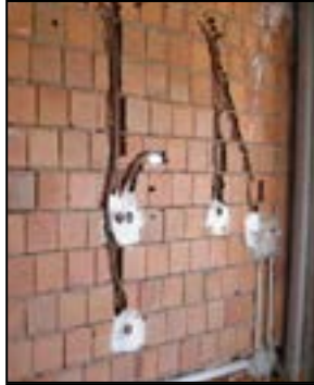
Fabrika İç Tesisat Tesisleri
